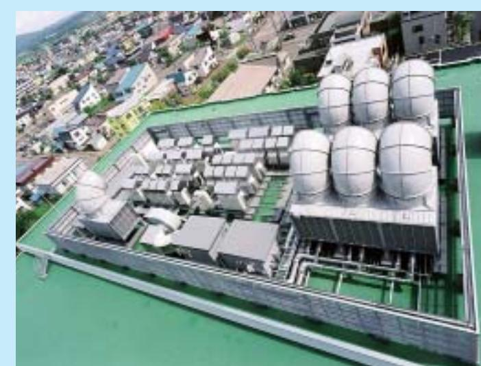
冷却能力 : 317kw 冷水温度 : 8°C~15°C
