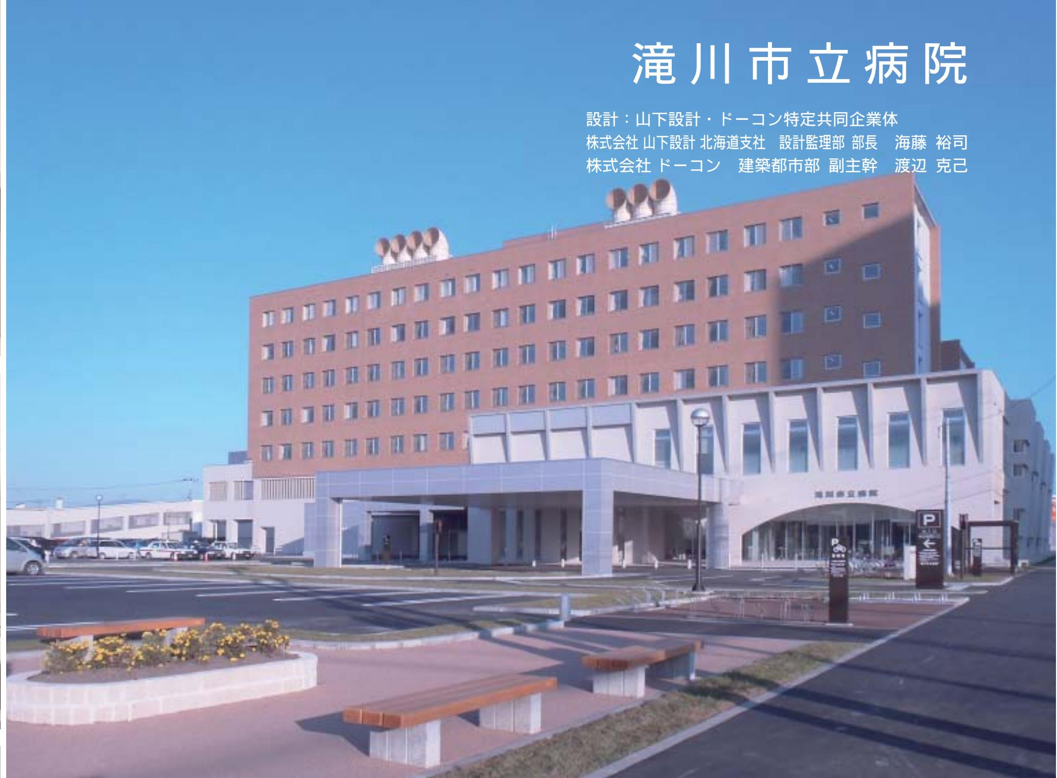
確実性が益々高まっている中、滝川市立病院では、免震構造を採用し、地震災害に対して十分稼動する施設として計画されています。また、温熱蓄熱環境の向上と軀体の長寿化を図るため、特に上層の病棟階は外断熱工法（レンガブロック積）を採用し、外観は滝川の自然風景に調和する色彩、素材、形体を選定しています。また、設備機器の2重化、燃料貯蔵、井水利用、トイレの分散配置などのBCPに有効な対応を行っています。（各設備概要参照）
