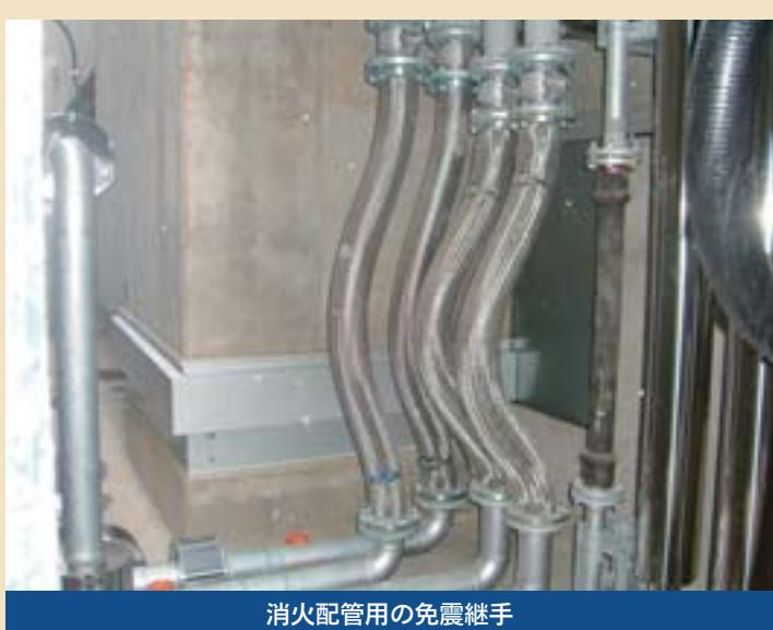
消防配管用の免震継手
