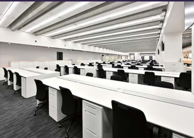
1階執務スペース：PCa床版を用いた開放的な執務エリアの空調はノズル制気口によりダクトレスとした
